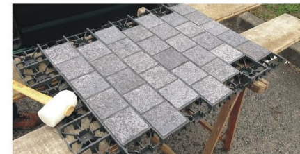
4- Emboîtez les pavés à l'aide d'un maillet blanc, sur plateau à hauteur d'Homme ou directement au sol pour les petites surfaces. Mélangez les nuances de granit.
