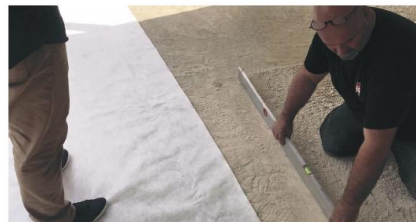
3- Régularisez la surface selon la nature de votre enrochement. Installez ensuite le géotextile et superposez les jonctions sur minimum 5 cm.
