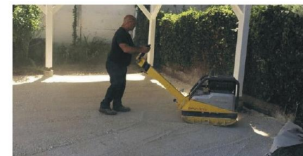
2- Compactez en 0/30 (cailloux) sur 15 cm minimum.
